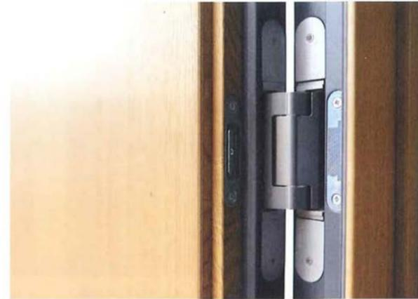
*Bei der Auswahl der Bandtechnik für die exklusiven Türelemente setzen die Mitarbeiter der RvE Manufaktur auf die verdeckt liegenden Türbänder der Marke Tectus von Simonswerk.
